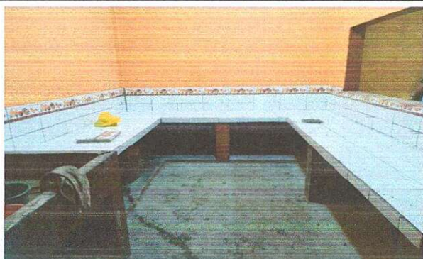
Foto 3: REMODELACION DE COCINA
