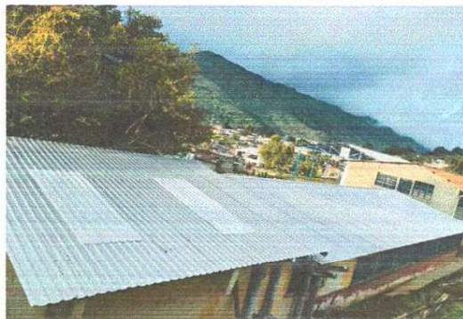
Foto 2: CAMBIO DE TECHO DE TRES AMBIENTES UNO DE COCINA Y DOS AULAS
